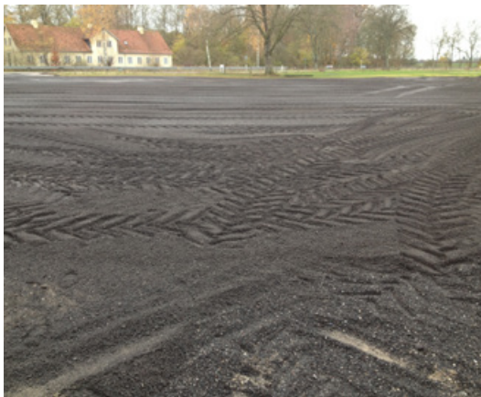
Anlæg af den nye bane
